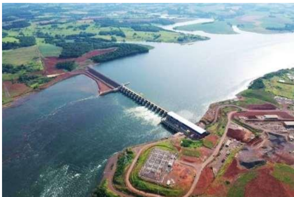
Fonte: Usina Hidroelétrica Baixo Iguaçu
